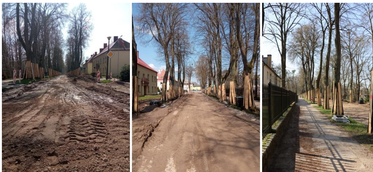
W trakcie realizacji inwestycji:
