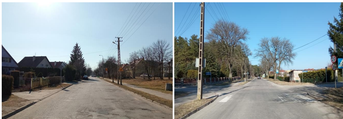
W trakcie realizacji inwestycji:
