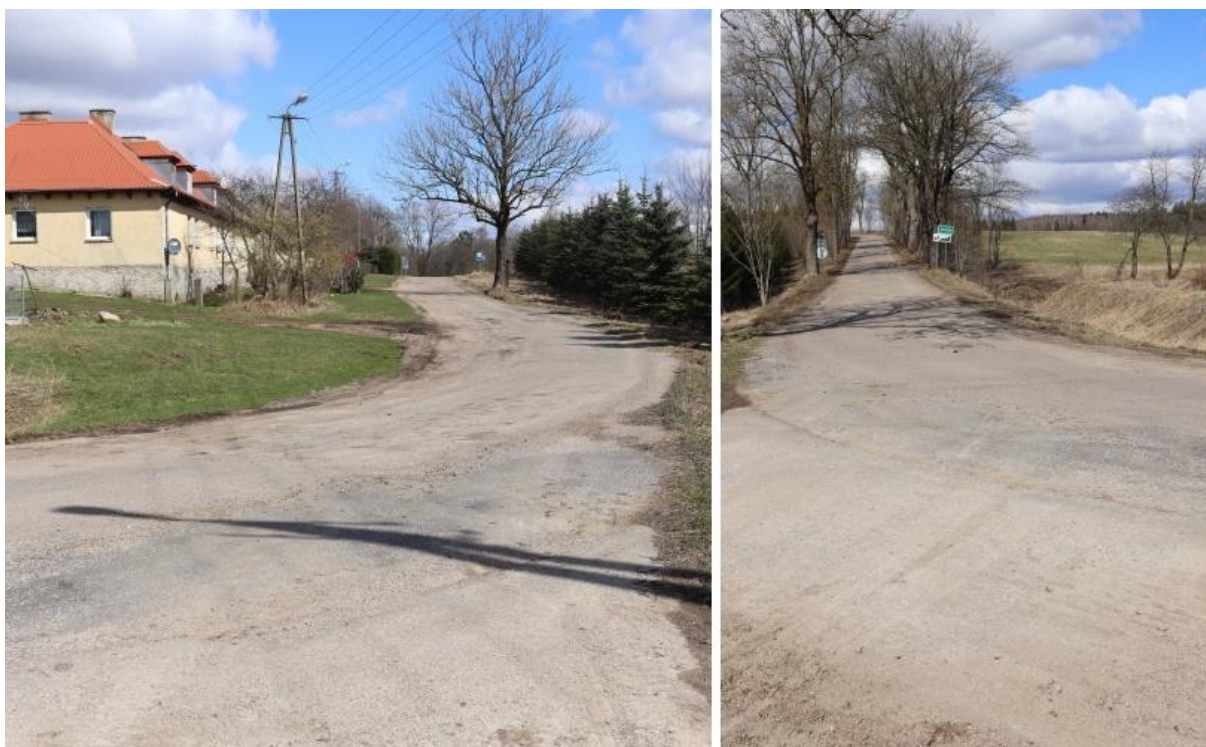
Droga 1790N Kowalki - Rudzie Przed realizacją inwestycji:
