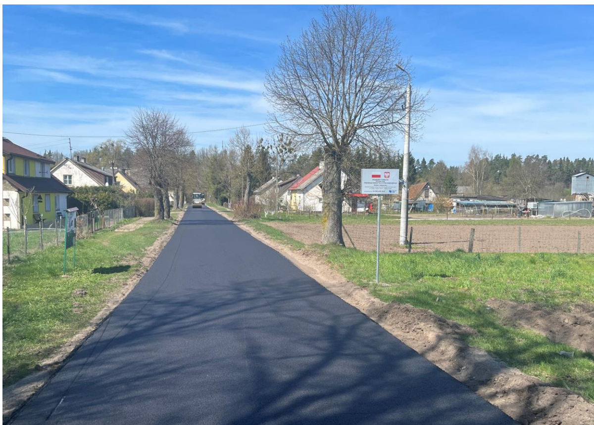
W trakcie realizacji inwestycji:
