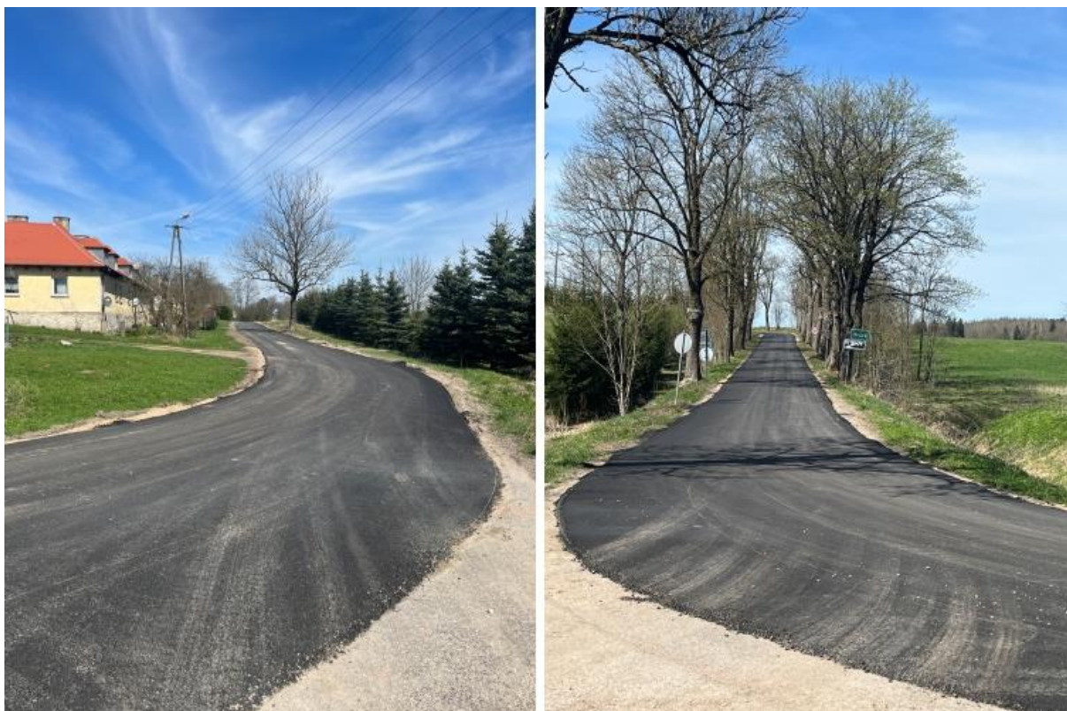
W trakcie realizacji inwestycji:
