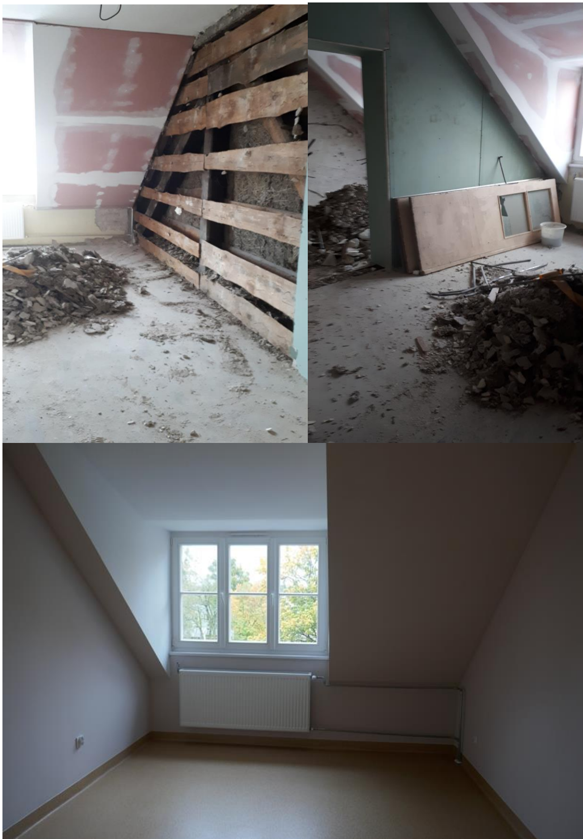
Adaptacja poddasza budynku szpitala w trakcie realizacji oraz efekt końcowy.
