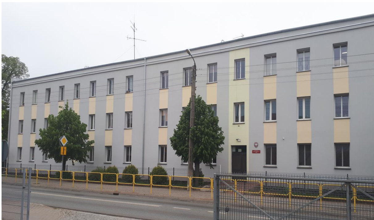
Termomodernizacja Zespołu Szkół Zawodowych w Gołdapi- projekt w trakcie realizacji
