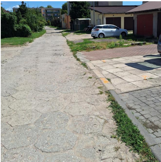
Przed realizacją inwestycji:
